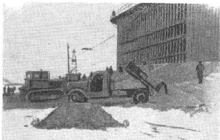
Фиг. 7. Обвалование шпунтовой ячейки.
