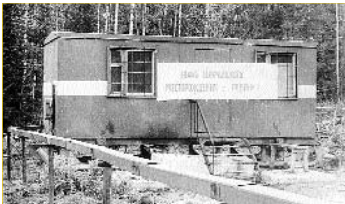
Вагончик операторной на ДНС «Шумы»
