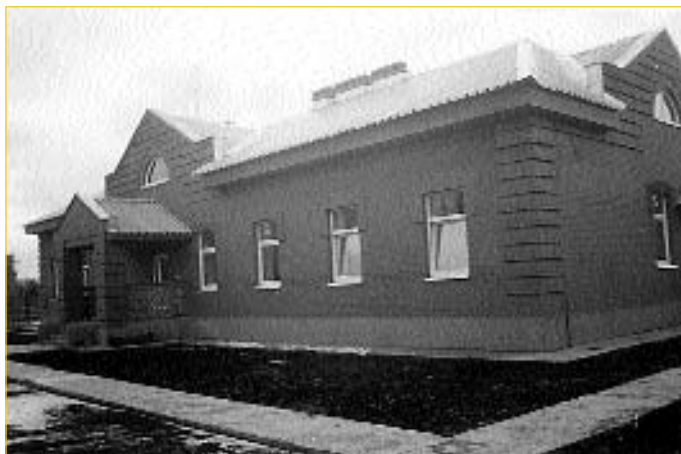
Опорный пункт бригады на Шатовском участке
