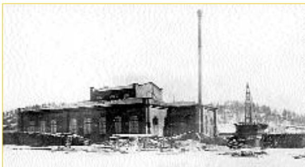
Стройплощадка ЦБК, кислотный цех. Справа скважина, заложённая буровым мастером И. М. Пичугиным
