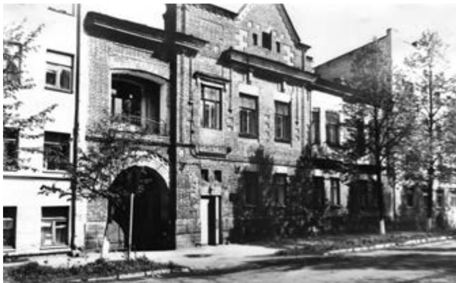
В этом здании (ул. Советская, 26) размещался центральный аппарат треста «Прикамнефть» (до 1937 г.), Молотовнефтекомбината (с 1942 г.), объединения «Пермнефть» (до 1957 г.). Фото 1980-х гг.
